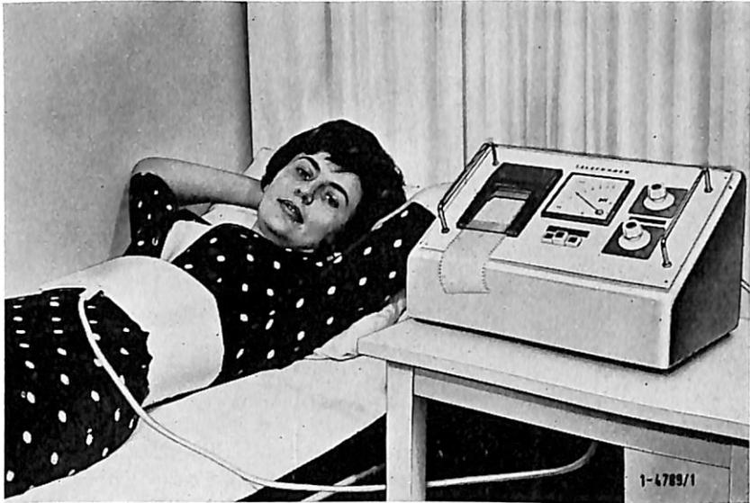
**Figure 1:** Le récepteur-enregistreur. Le patient porte déjà l'antenne.
